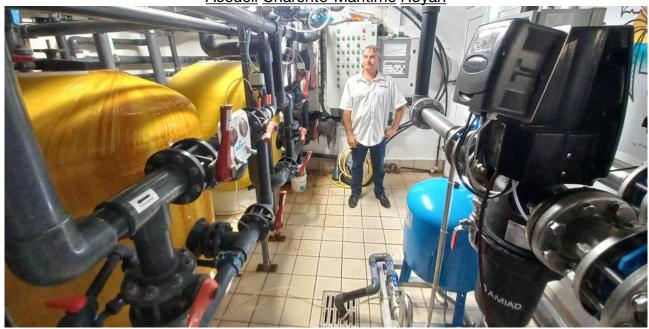
À gauche, deux imposants filtres à sable. À droite, le système imaginé par William Lezeau, dont un filtre habituellement utilisé sur les systèmes d'irrigation. © Crédit photo : R.C
